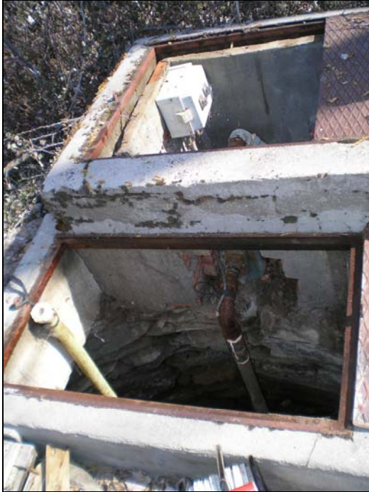
14. Pozo excavado junto a sondeo perforado a 200 m de la Laguna de la Fuente Santa. Corresponde al punto de agua nº 6 en la Figura 2.
